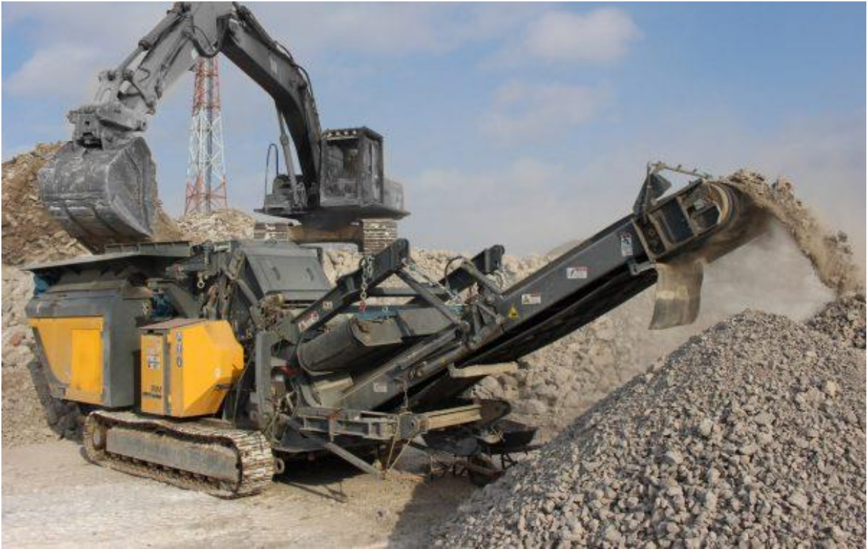
Concasseur mobile fabricant des graves routières recyclées
