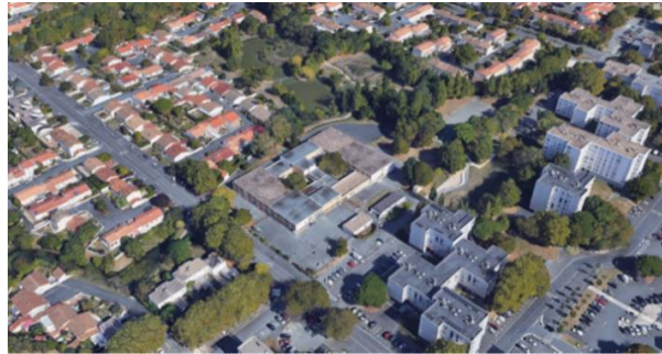
Figure 1: Réhabilitation du Groupe Scolaire Lavoisier
