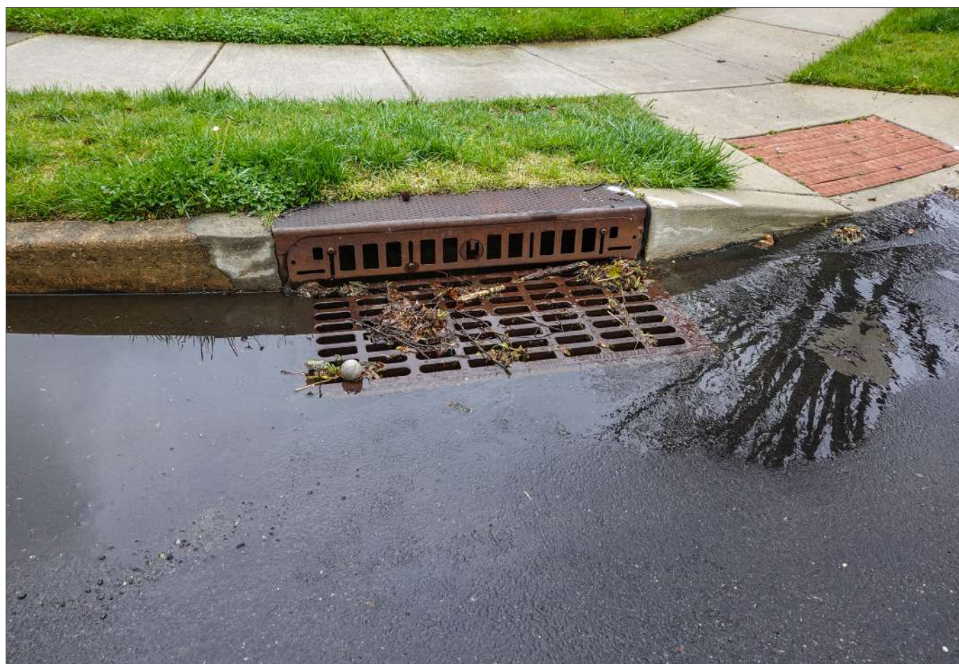
Grille prévenant la fuite de déchets vers les masses d'eau lors de fortes intempéries / Alan / AdobeStock
